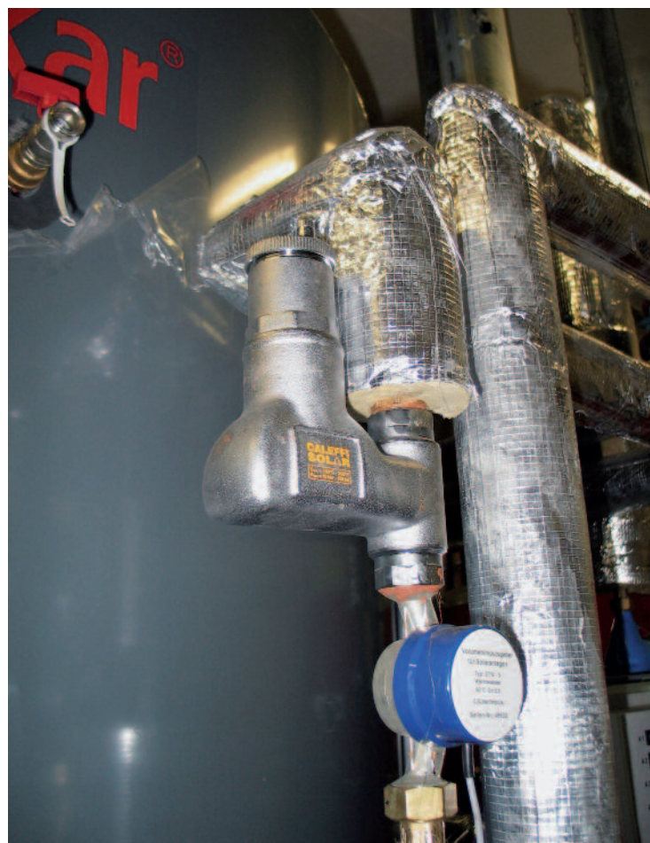
Die Mikroblasenabscheider der Serie Discal Solar 251 stellen eine kontinuierliche Entlüftung der Anlage sicher.
