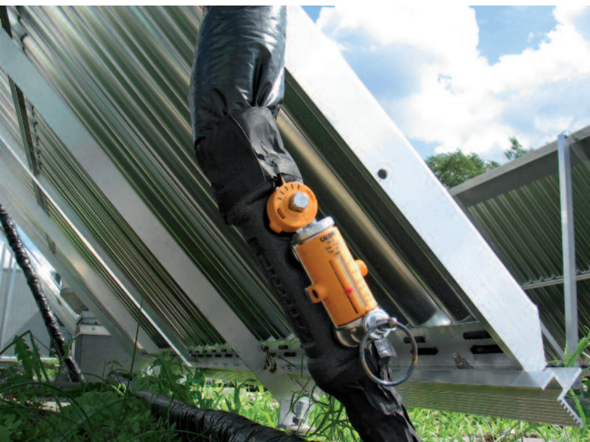
Der hydraulische Abgleich der, auf einem Flachdach aufgeständerten Solar-kollektoren erfolgt mit dem Strangregulierventil Setcal Serie 258 Solar.
